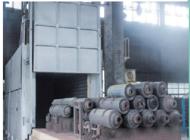
600KW 電熱爐 600KW electrical annealing furnace
