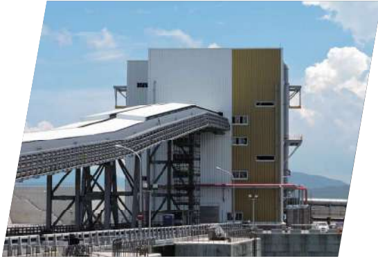
林口電廠煤礦轉運塔 TPC Linkou Coal transport tower
