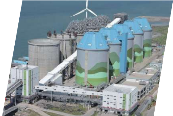
林口電廠煤倉區輸送帶 TPC Linkou coal bunker conveyor
