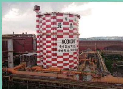
中鋼 轉爐氣體儲槽更新 CSC LDG holder
