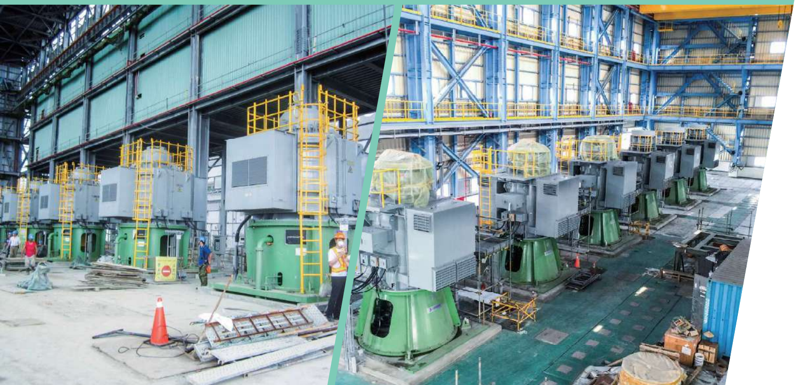
大林電廠 CWP 現場安裝 TPC Talin CWP on site installation
