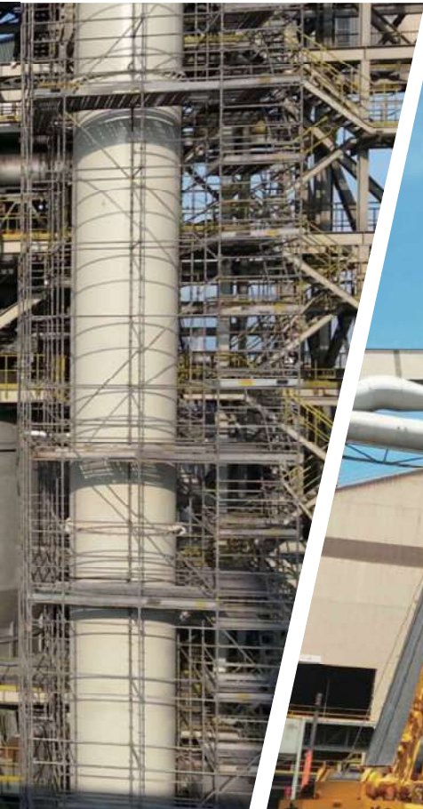
中龍乾式淬火設備 DSC CDQ facility
