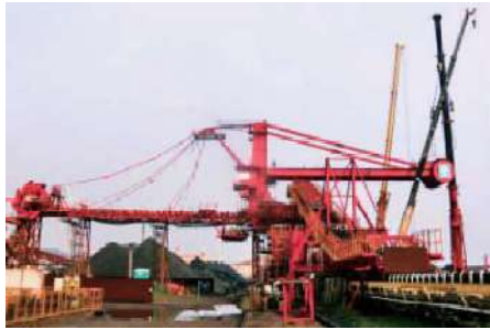
中鋼堆取料機 CSC 4,500/2,000 T/H Stacker Reclaimer
