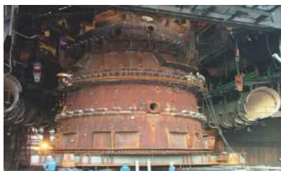
中龍高爐爐殼 DSC Blast furnace shell
