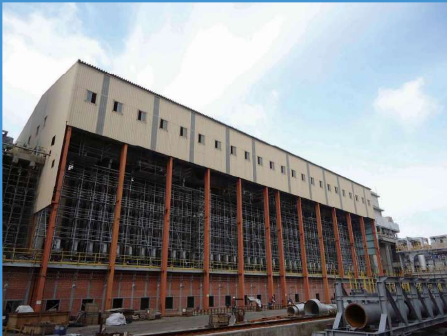
中龍煉焦爐 DSC coke oven
