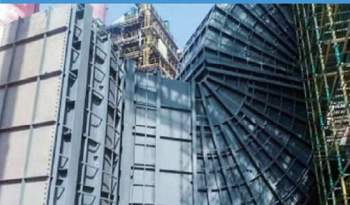
中鋼 2SP FGD/SCR 製裝工程 CSC 2SP FGD/SCR construction.
