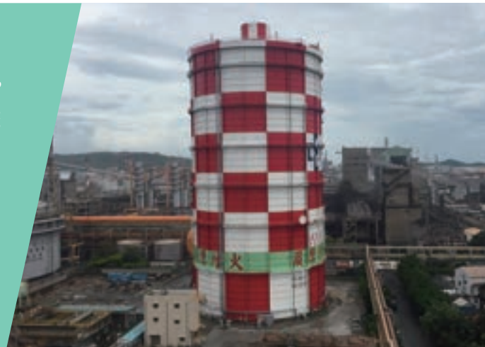
中鋼高爐氣儲槽 CSC BF Gas holder
