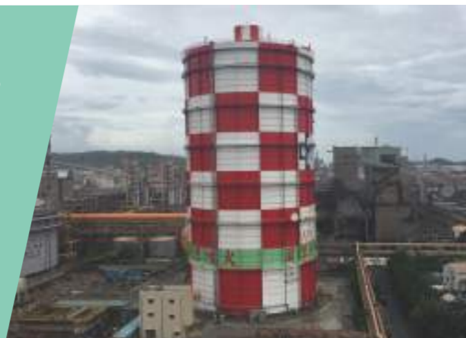
中鋼高爐氣儲槽 CSC BF Gas holder
