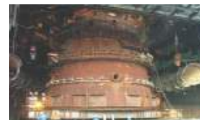
中龍高爐爐殼 DSC Blast furnace shell
