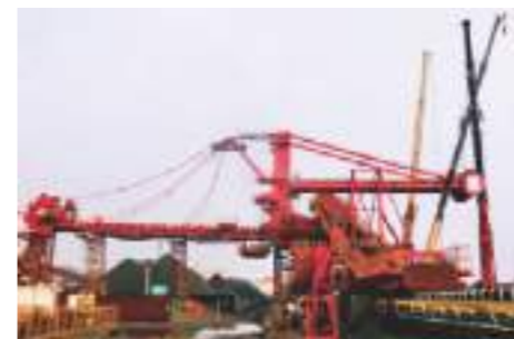
中鋼堆取料機 CSC 4,500/2,000 T/H Stacker Reclaimer
