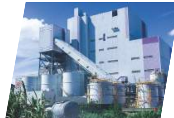
林口電廠大傾角輸送帶 TPC Linkou Coal Steep angle conveyor
