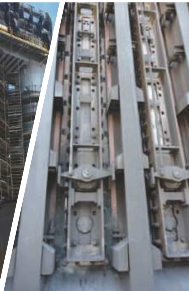
煉焦爐爐門框 Coke oven door frame
