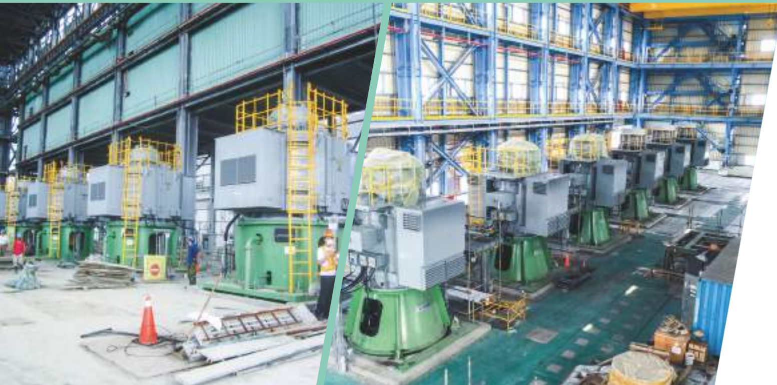
大林電廠 CWP 現場安裝 TPC Talin CWP on site installation
