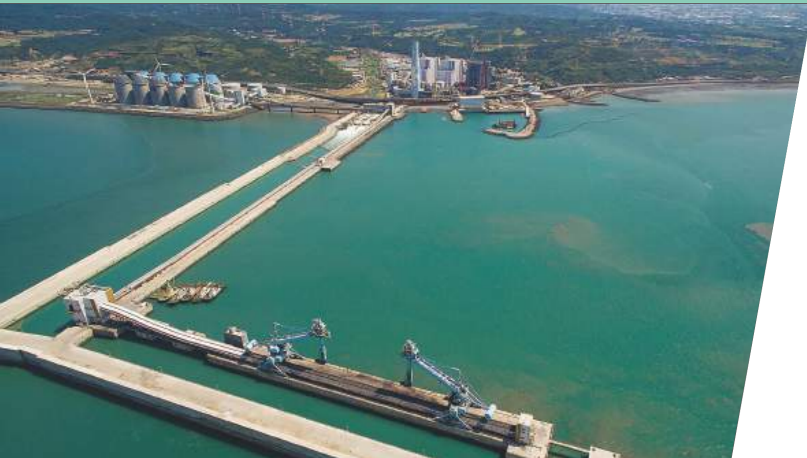
林口電廠氣浮式輸送機 TPC Linkou Flow Dynamics Conveyor (FDC)
