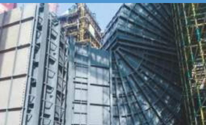
中鋼 2SP FGD/SCR 製裝工程 CSC 2SP FGD/SCR construction.
