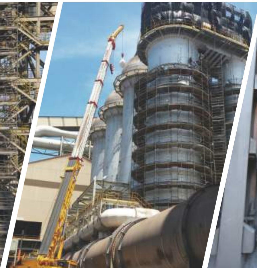
中龍熱風爐 DSC Hot blast stove
