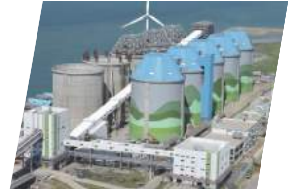
林口電廠煤倉區輸送帶 TPC Linkou coal bunker conveyor
