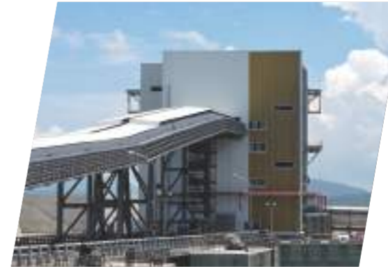
林口電廠煤礦轉運塔 TPC Linkou Coal transport tower
