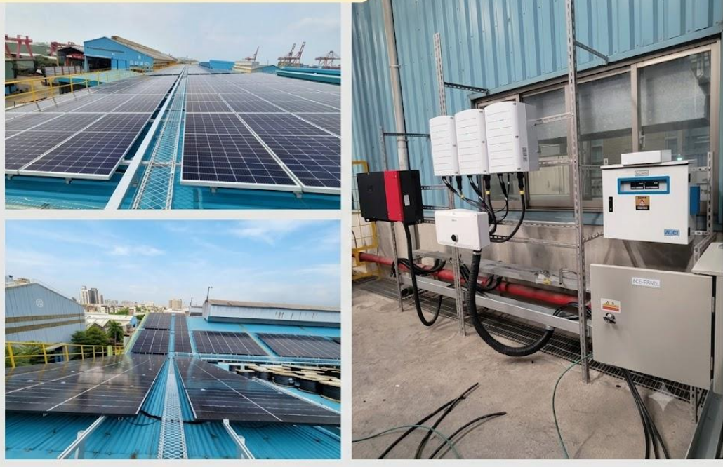
中鋼機械廠房屋頂裝設太陽能發電設備
