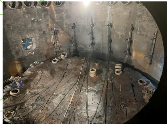
殘銑「金鋼石繩鋸」切割作業
