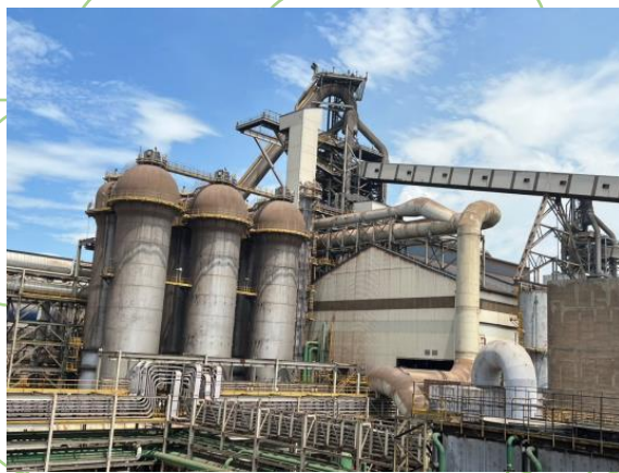
中機承攬中龍壹號高爐第一爐代大修爐本體製裝工程
